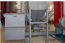
Zentraler Asche-Container\* mit 60 bis 1250 Liter Fassungsvermögen je nach Anlagengröße, in Sonderausführung bis 3 m<sup>3</sup>.
