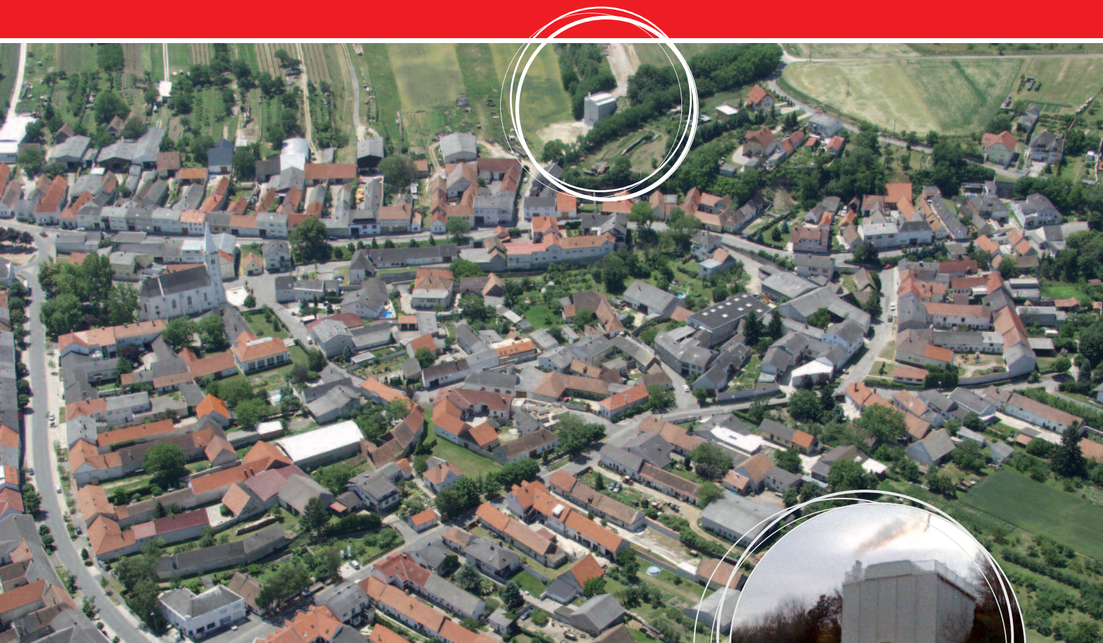
Stadsverwarmingscentrale Neckenmarkt, verwarming van 117 gebouwen Installatie: 2 x 400 kW BioMatic en 1 x 800 kW BioFire
