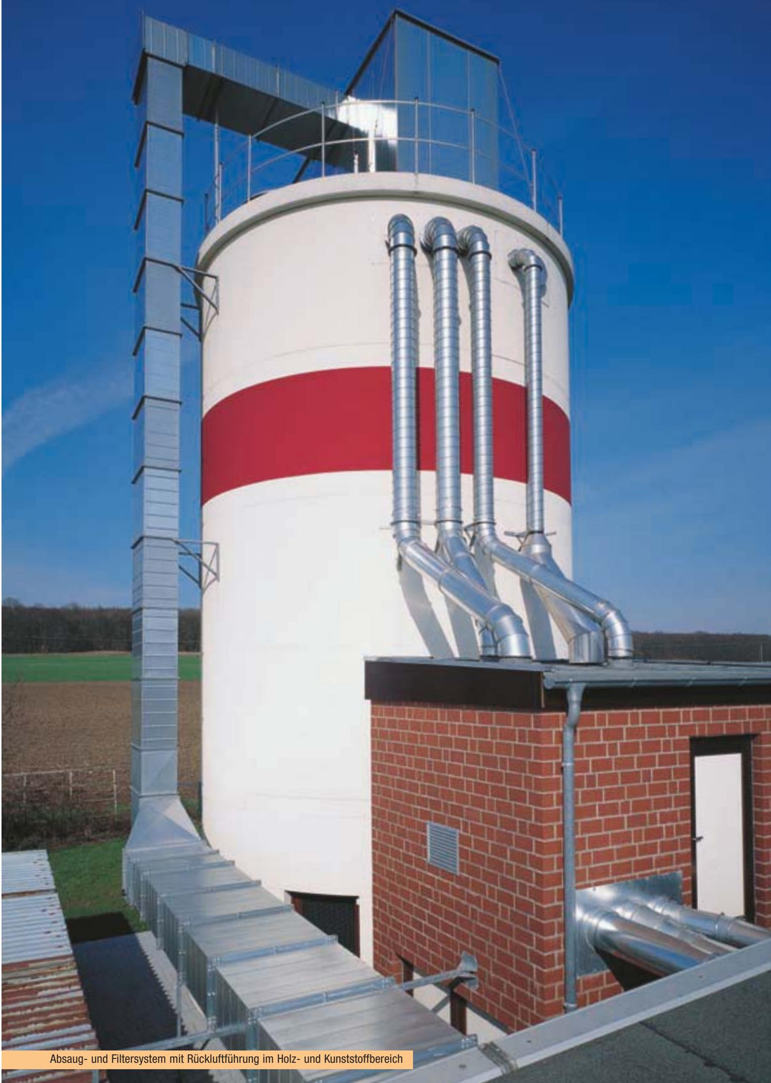
Absaug- und Filtersystem mit Rückluftführung im Holz- und Kunststoffbereich
